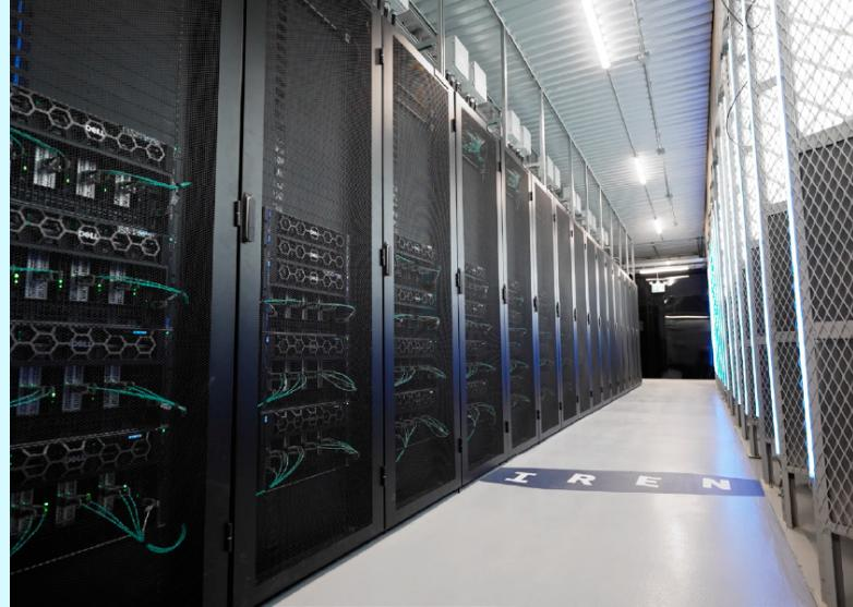
由于 IREN 的数据中心位于美国的一些最温暖的地区，正合适选择 PowerEdge XE9680 — 它在高温环境中具有出色的可靠性。该服务器可在 35 °C 环境中完全利用外部空气进行冷却，实现全年性能稳定，这对 IREN 至关重要，可满足其客户尽量缩短停机时间的需求。
