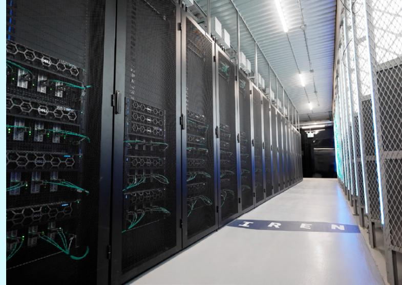
Com os data centers da IREN localizados em alguns dos ambientes mais quentes dos EUA, o PowerEdge XE9680 foi escolhido por sua confiabilidade em altas temperaturas. Capaz de funcionar usando refrigeração a partir de ar 100% externo em um calor de 35 graus, ele fornece desempenho consistente o ano todo, o que é essencial para a IREN, pois ela busca minimizar o tempo de inatividade para seus clientes.
