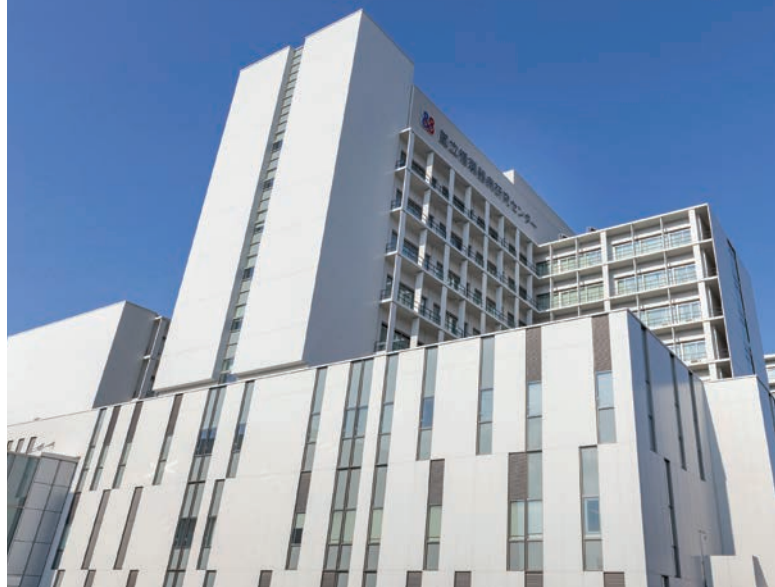
2019年7月に大阪府吹田市岸部に移転した新たな国立循環器病研究センター。地上12階・地下2階・延床面積12万9,881平方メートルの規模がある。
