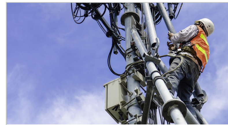
Interventions sur site
